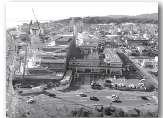
新庁舎の工事現場(11月末現在)
